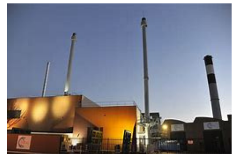
Centrale de chaleur de Bondy
